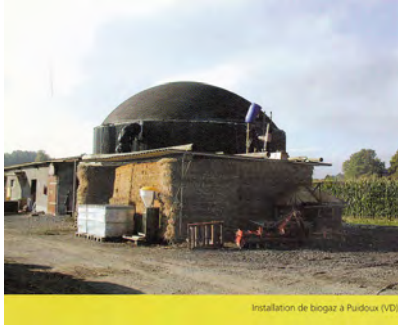
Installation de biogaz à Puidoux (VD)
